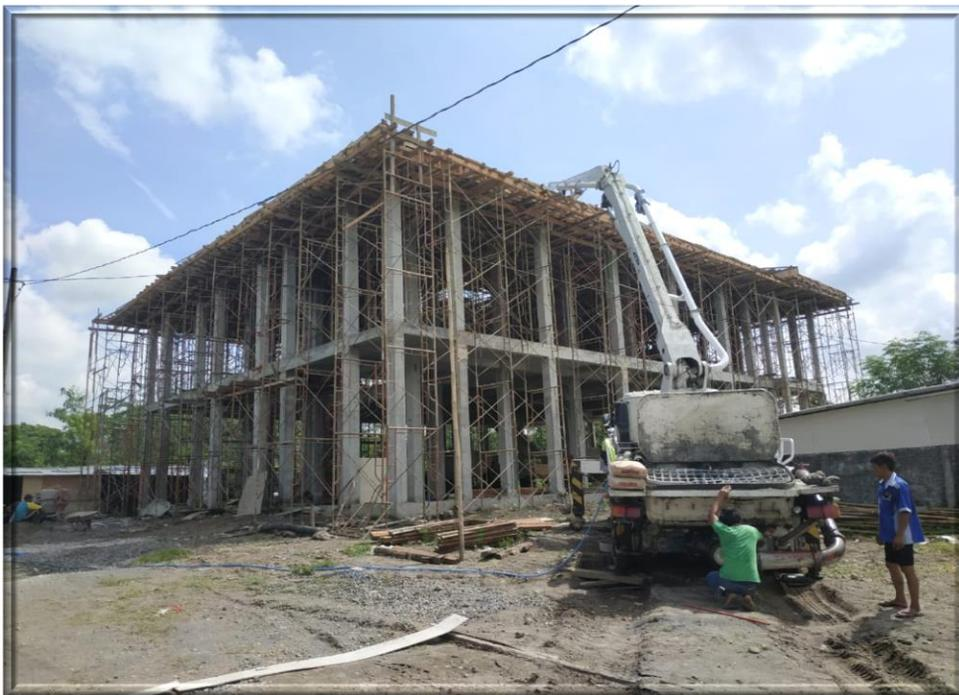
Gambar 8. Mengecor atap lantai 2 (dak)
