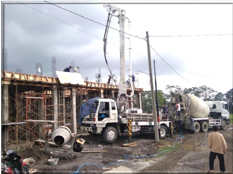
*Gambar 6. Pengecoran atap lt. 1*
