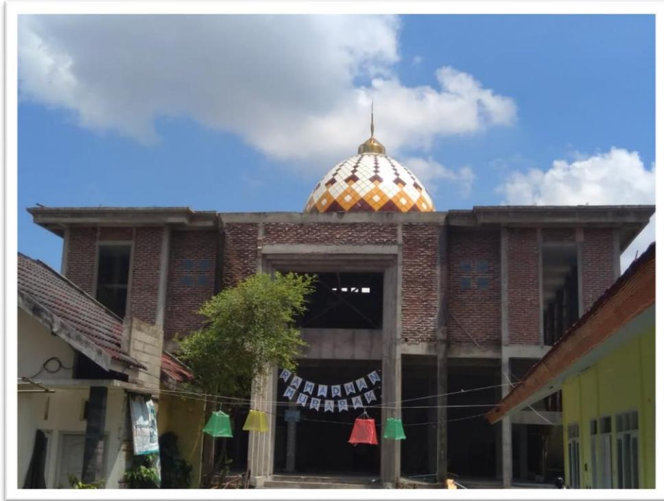
Gambar 10. Pemasangan dinding lantai 2 dan pemasangan kubah
